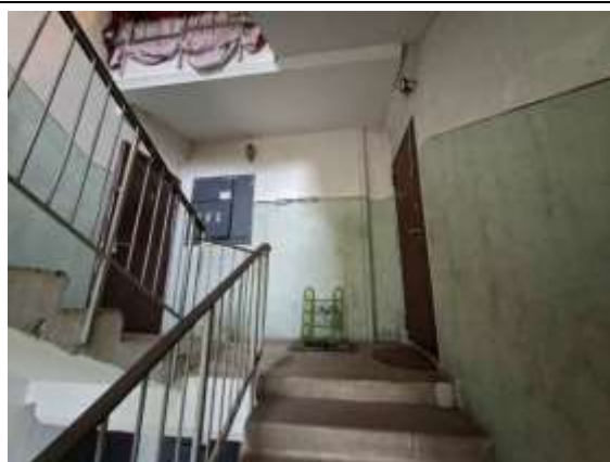
2.stāva kāpņu telpa
